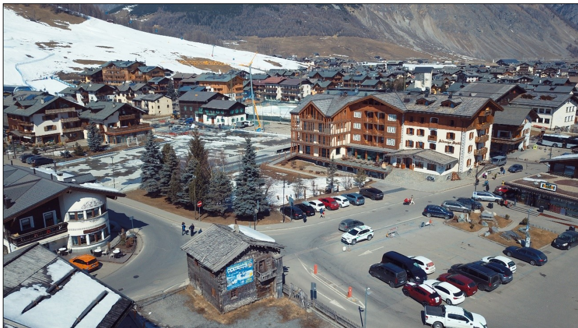
Foto.1 –Vista aerea dell'area di intervento da sud-ovest.
