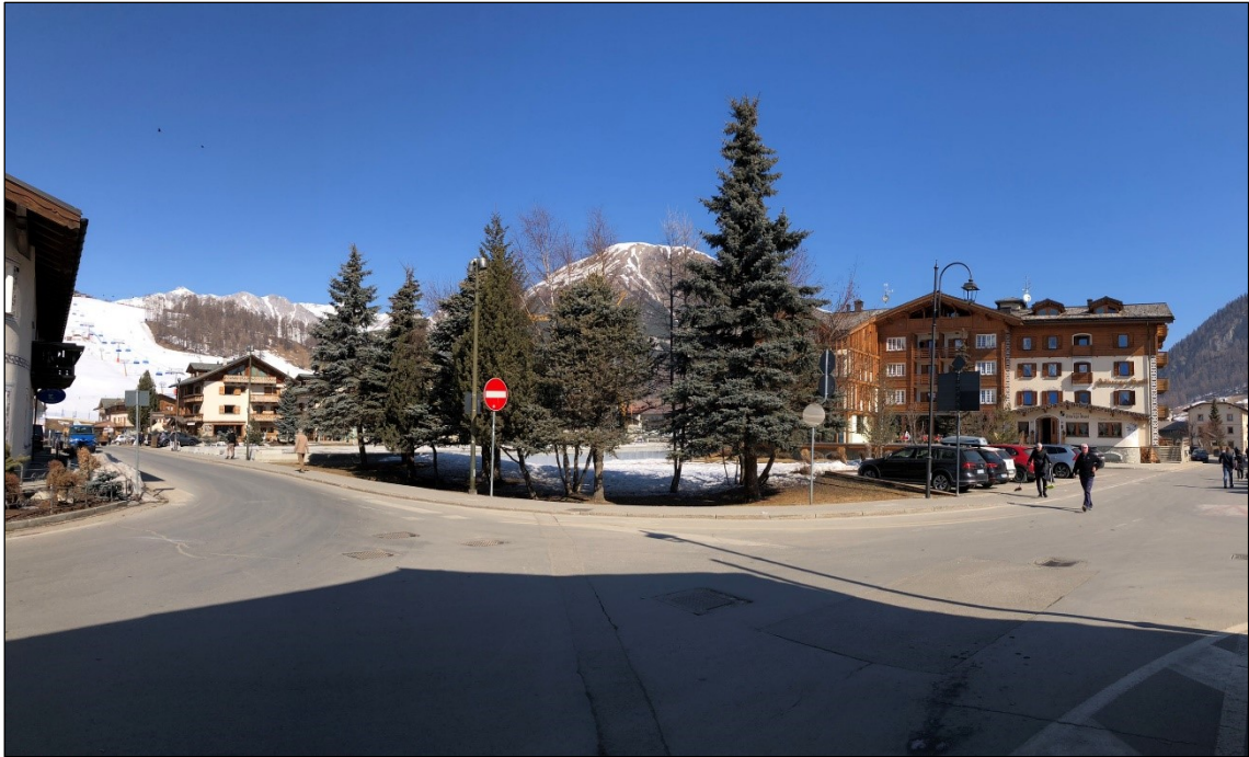
Foto.3 –Vista principale dall'incrocio stradale tra via Botarel e via Dala Gesa.
