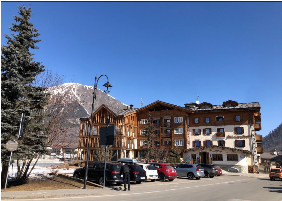
Foto.4 –Vista ravvicinata del fabbricato esistente.
