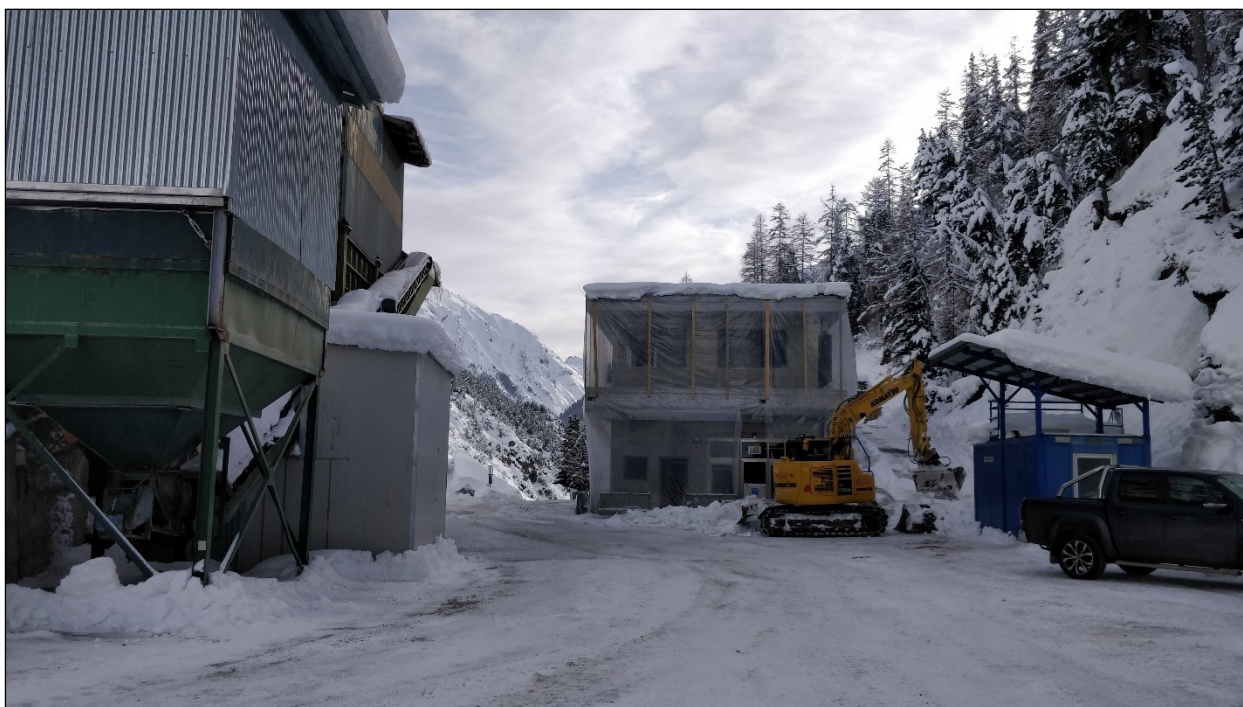
Foto.7 – Particolare del fronte ovest.
