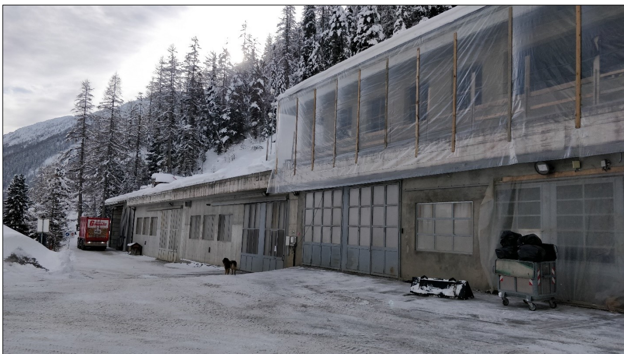
Foto.8 – Particolare del fronte nord.
