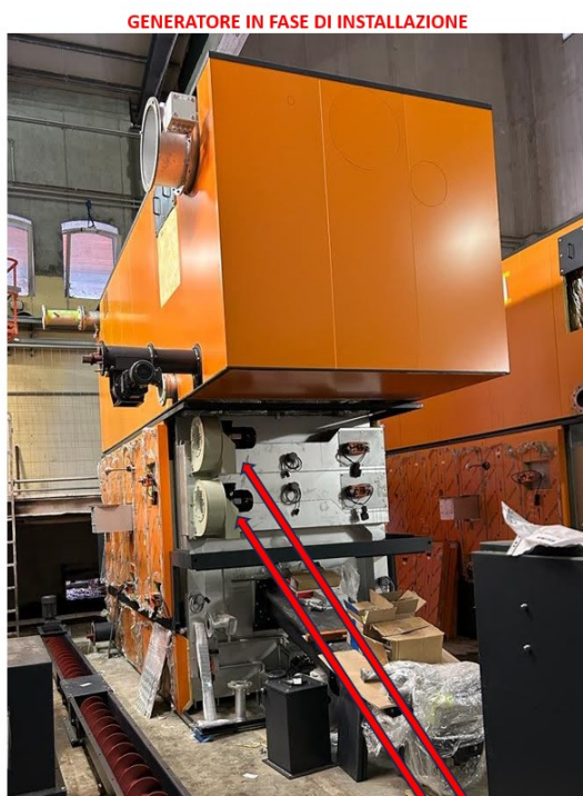
Ventilatori bordo caldaia
