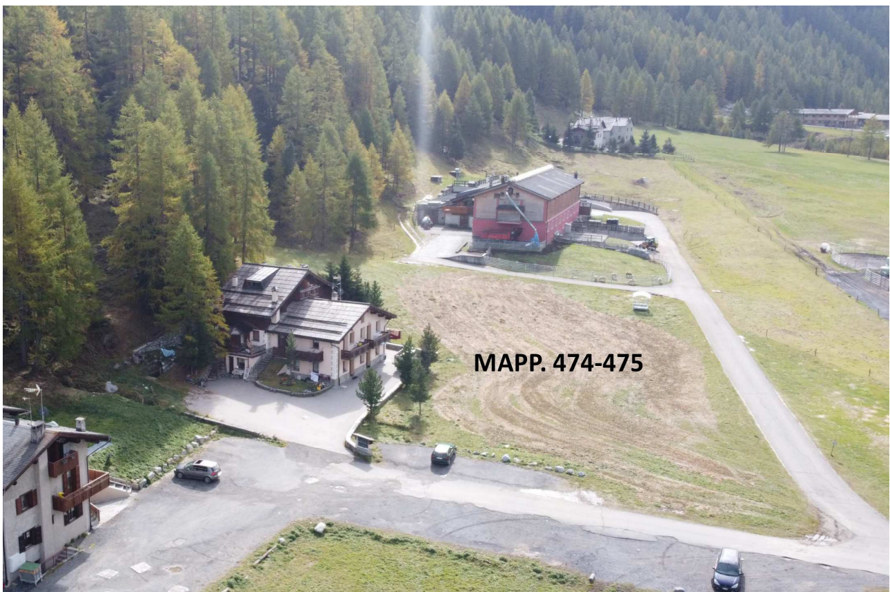
Immagine 12 – vista aerea verso SUD
