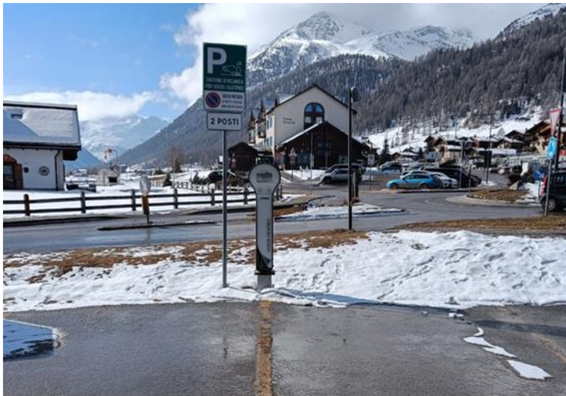
Foto 4: Postazione di ricarica parcheggio via Borch
