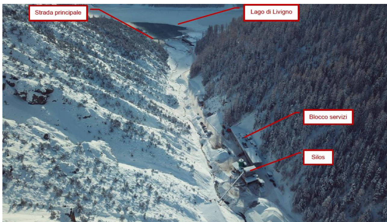
Figura 5 - Panoramica dello stato di fatto (stato di fatto)
