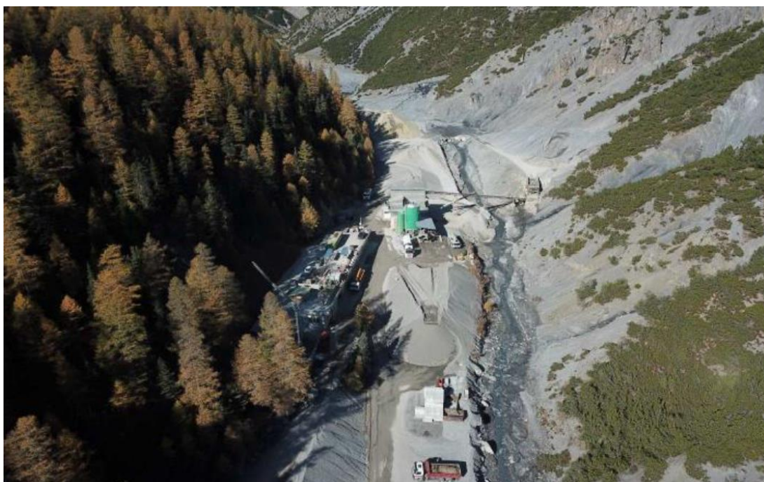
Figura 7 - Vista dell'area allo stato di fatto
