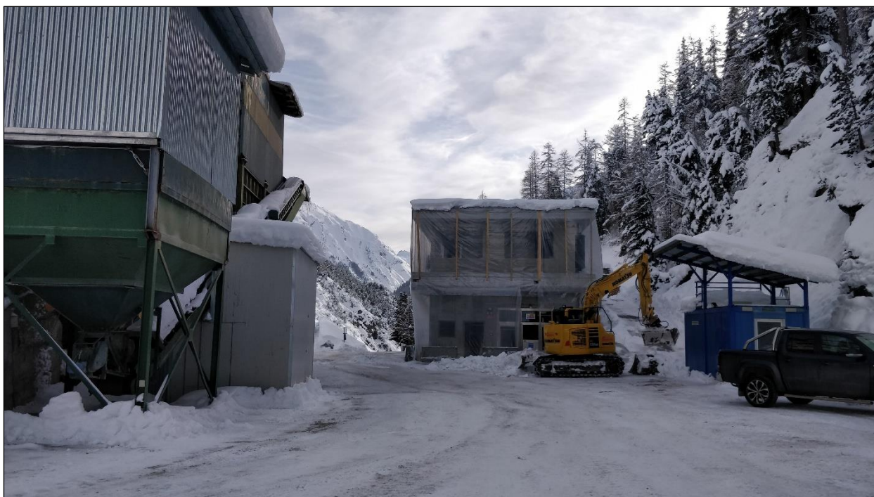
Foto.7 – Particolare del fronte ovest.
