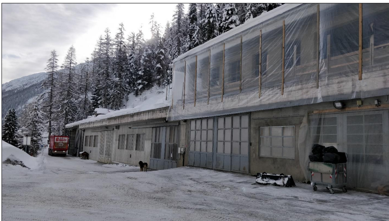
Foto.8 – Particolare del fronte nord.
