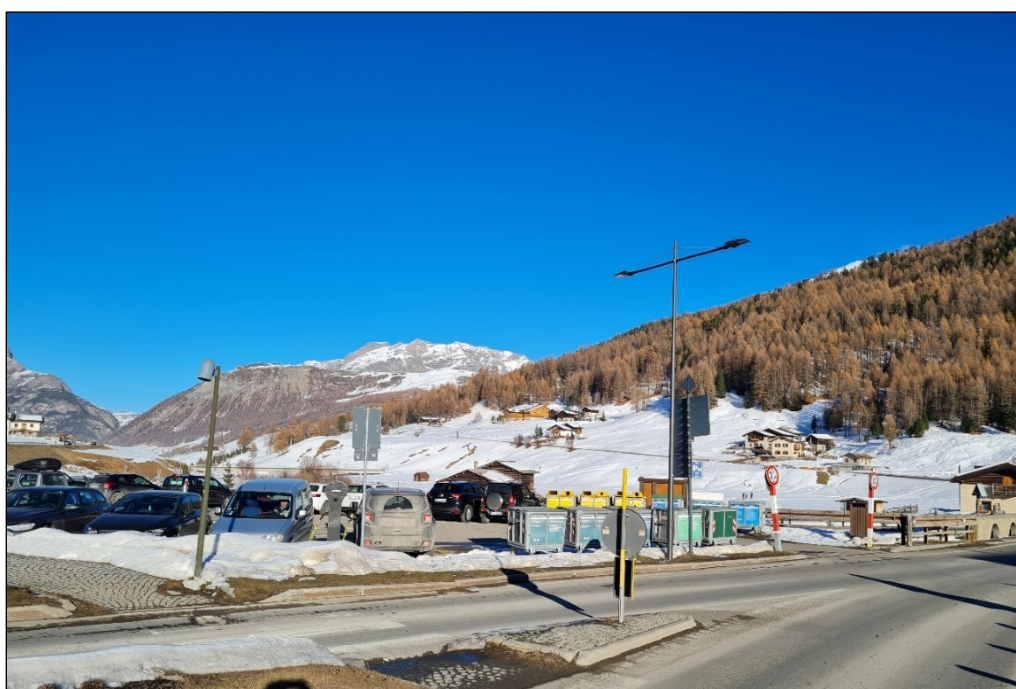
Foto.2- Vista frontale della posizione della futura piazzola di raccolta rifiuti urbani in corrispondenza del parcheggio all'incrocio di via Freita all'incrocio con via Borch.
