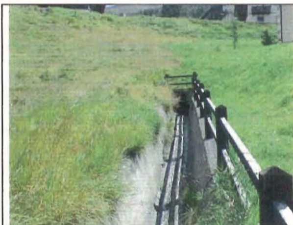
Foto 25 Tratto canalizzato allo sbocco del primo tombamento
