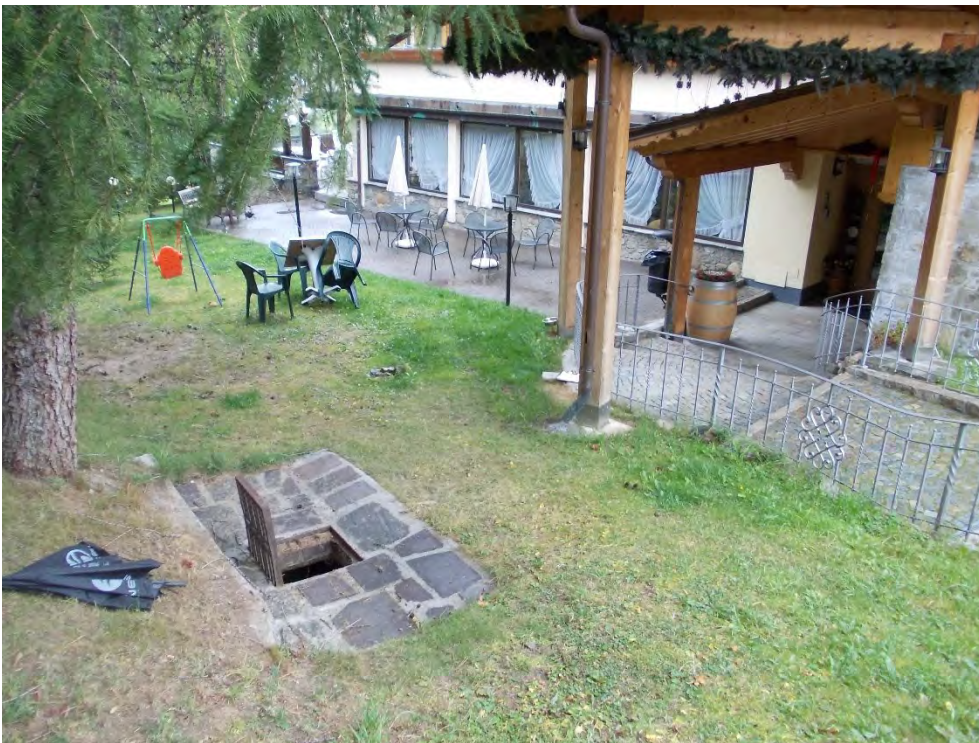
Foto 6 e 7 – Pozzo di salto intermedio
