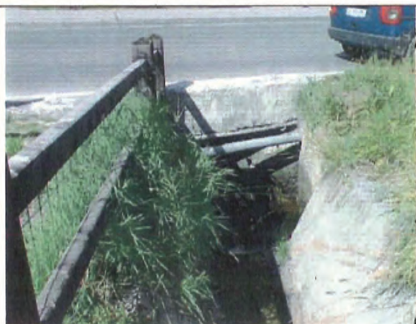
Foto 26 Imbocco del secondo tratto tombato
