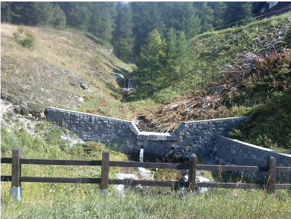
Foto 1 e 2 – Opere di regimazione idraulica a monte della Via Teola.
