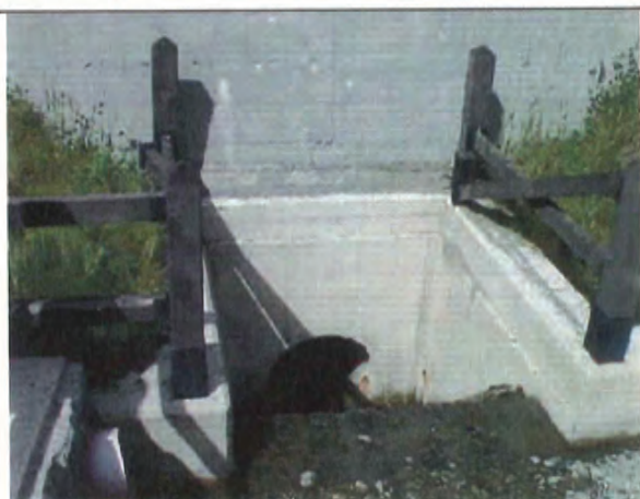
Foto 20 Sistema di briglie e inizio tratto tombato (ultimo salto e imbocco)
