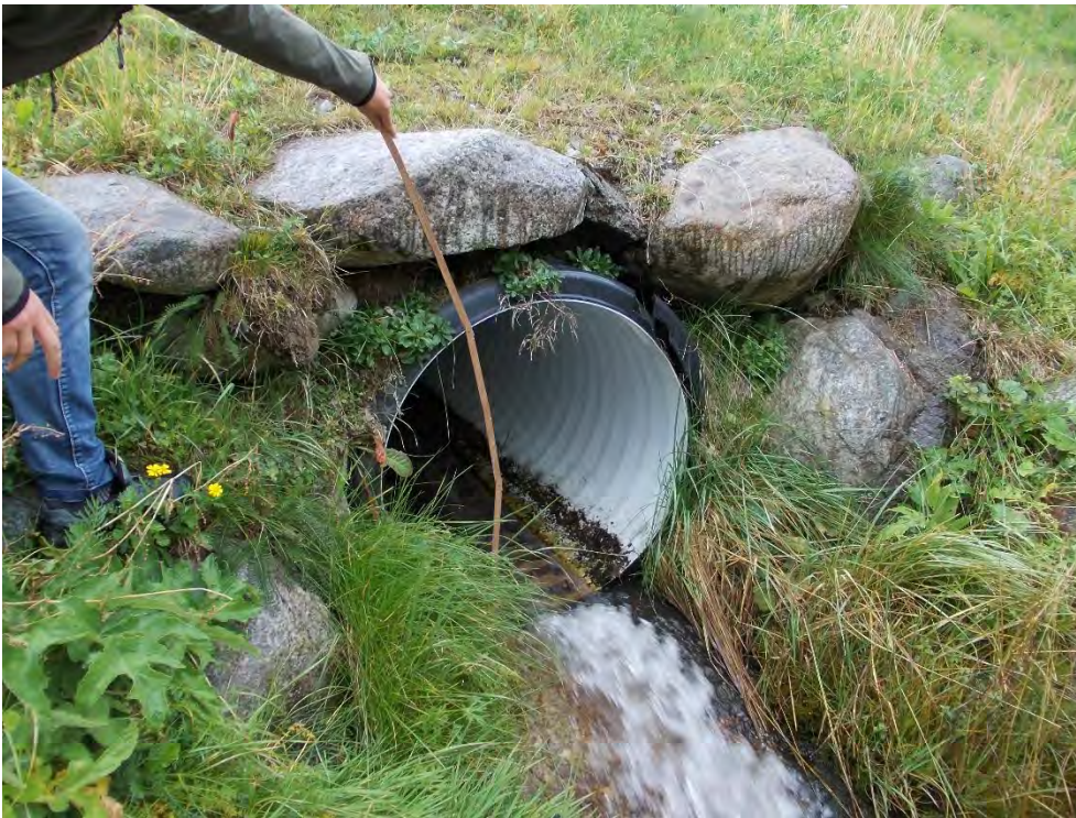
Foto 10 – Tubo ecopal corrugato esterno Ø 80 cm, in corrispondenza dello scarico nello Spöl
