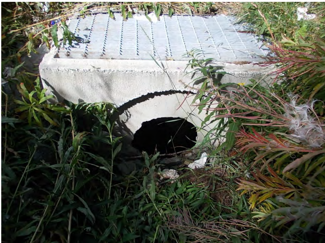
Foto 15 – Q. 2110 m s.l.m. pozzetto di innesto del tratto tombato di attraversamento della SS 301
