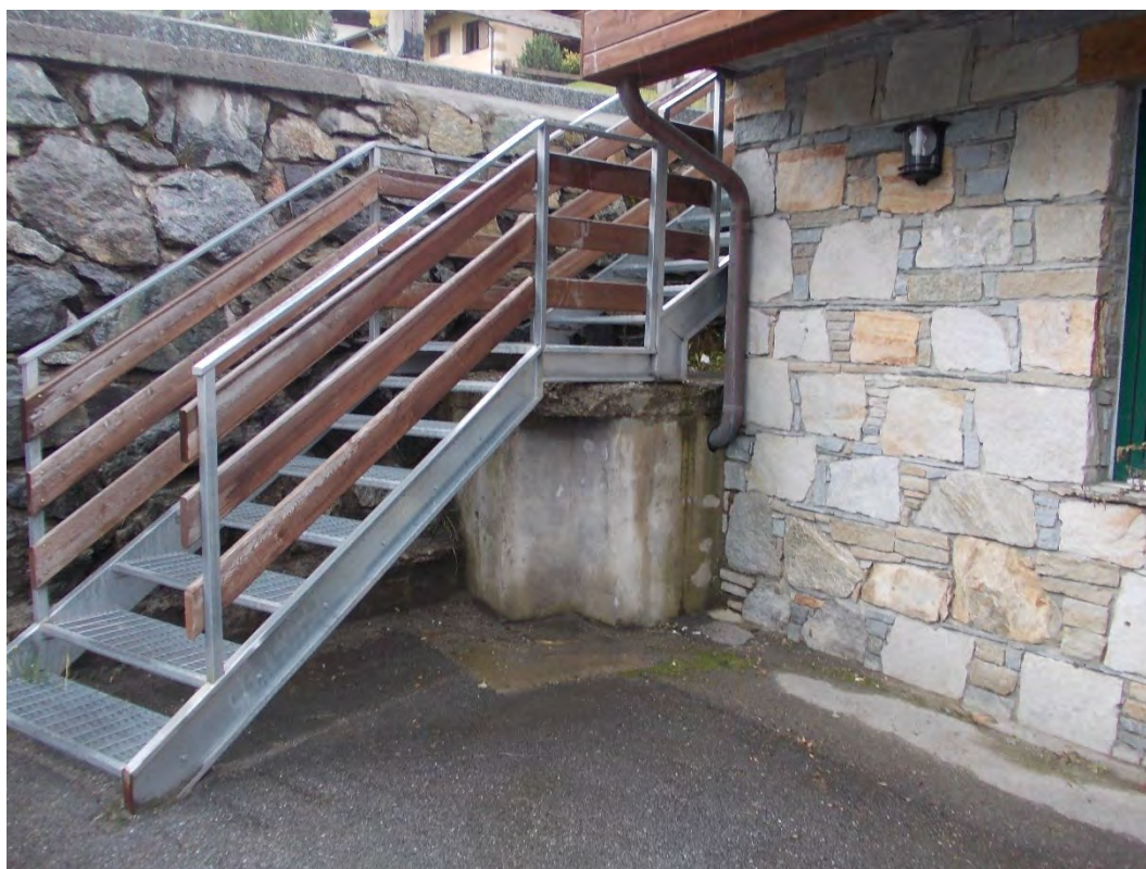
Foto 5 – Pozzo di salto iniziale, posizionato immediatamente a valle del muro di sostegno della S.S. 301
