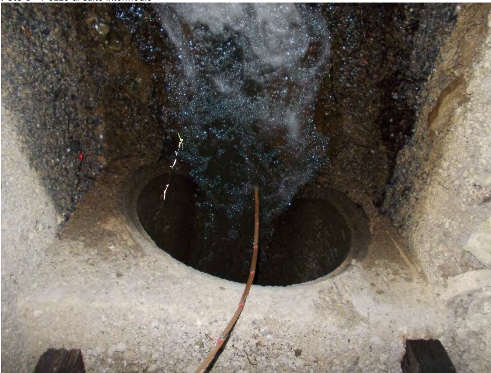
Foto 9 – Pozzo di salto intermedio
