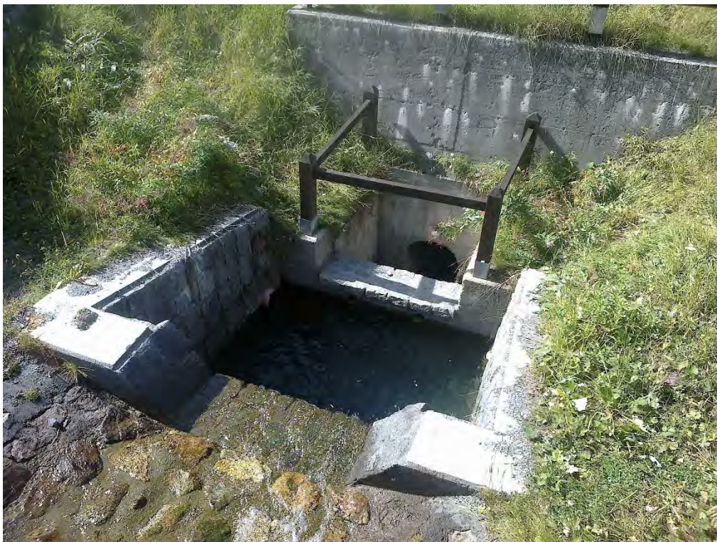
Foto 3 – Innesto tratto tombato immediatamente a monte della Via Teola.
