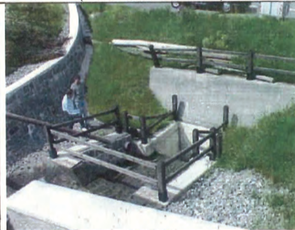
Foto 22 Sistema di briglie e inizio tratto tombato (visione da monte)
