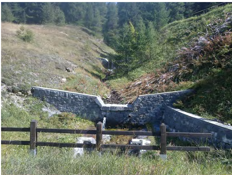
Foto 21 e 22 – Zona dove è prevista la nuova sacca di deposito del trasporto solido mediante svasso del materiale presente e trasformazione a briglia selettiva dell'attuale briglia di contenimento.
