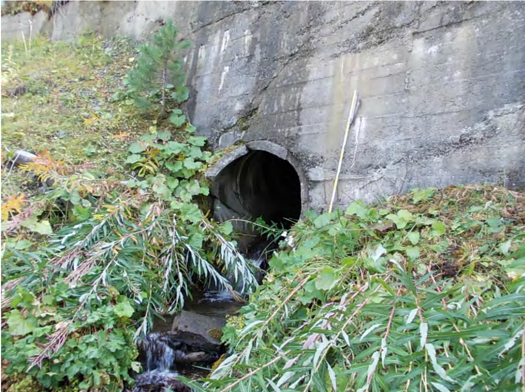
Foto 16 – Q. 2100 m s.l.m. uscita del tratto tombato attraversamento della SS 301
