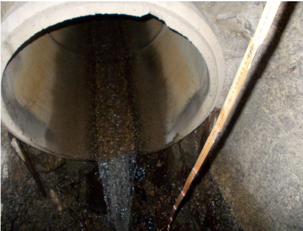
Foto 8 – Pozzo di salto intermedio
