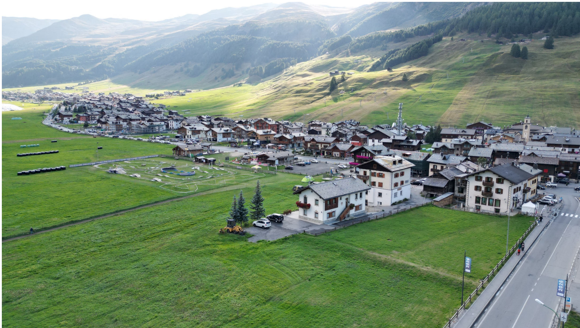
Foto 2 – vista aerea da nord dell'area oggetto d'intervento
