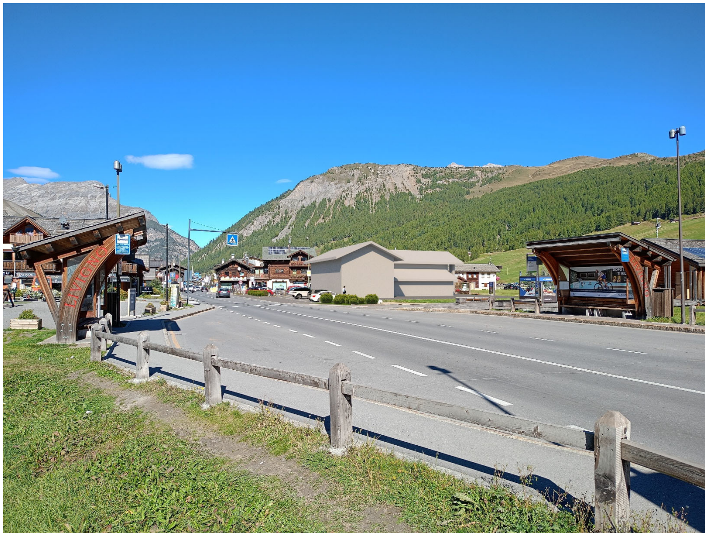
Foto 4 – vista da Via Isola verso sud – edificio e parcheggio antistante
